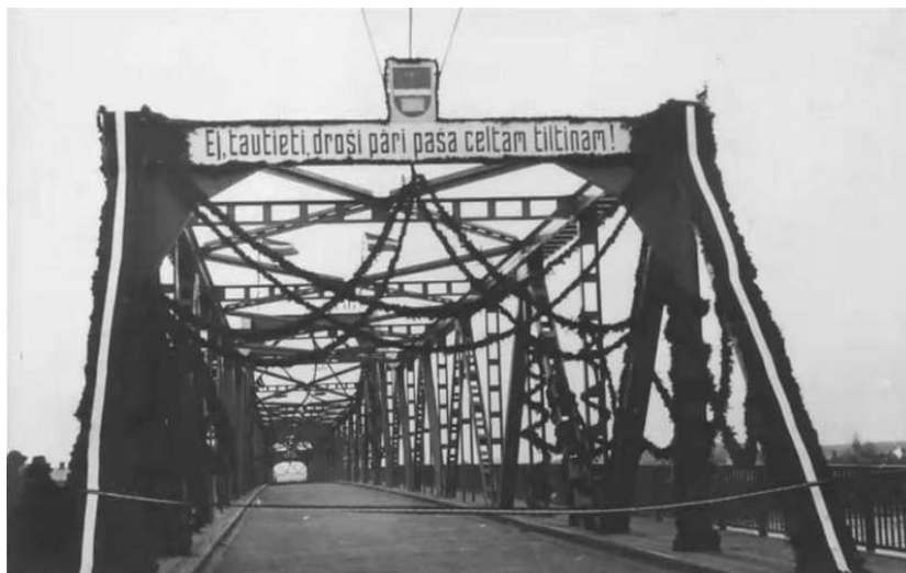
Fig. 2. Placard on Vienības Bridge
